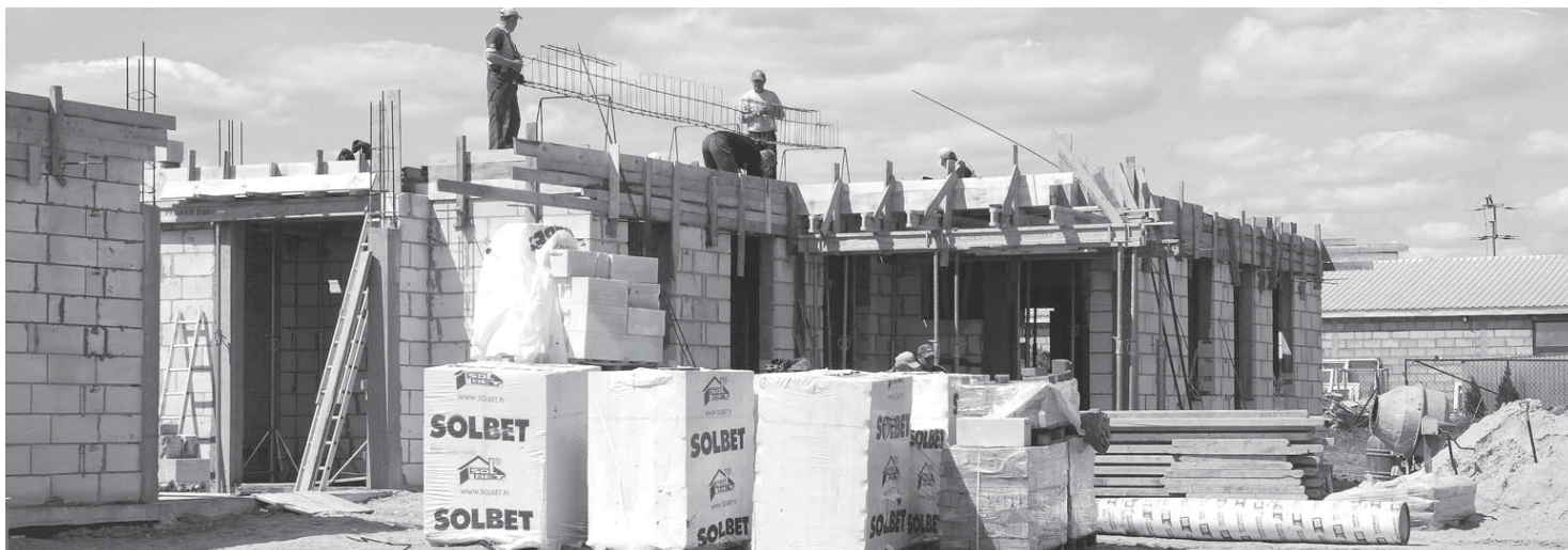
Budowa świetlicy w miejscowości Krynka, fot. A. Pulik
